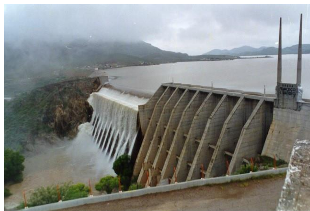
Figura A1.3. Presa Francisco. I. Madero (SINA, 2022)
